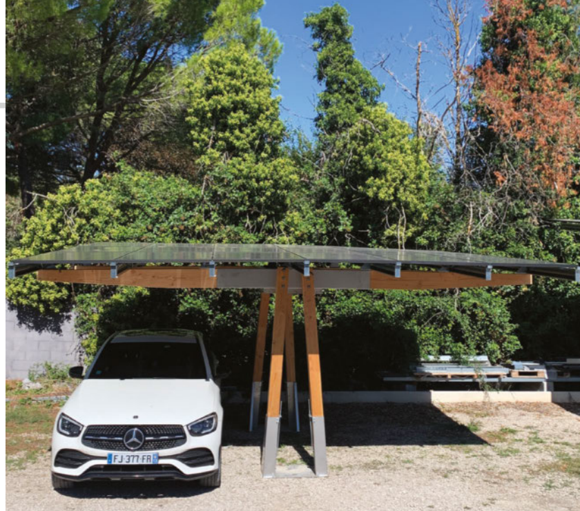
L'installation solaire du camping peut prendre la forme d'une ombrière de parking.
